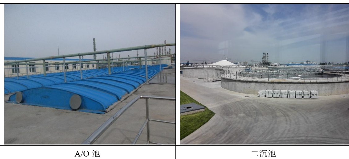
图 4.1-2 污水处理场（依托工程）现场照片
